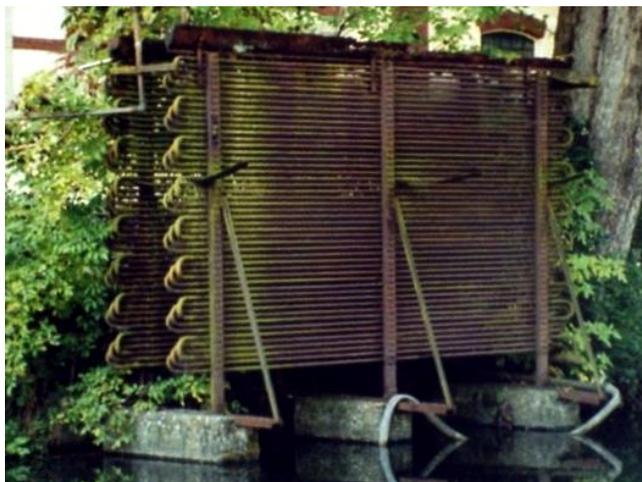
In der Anlage befindet sich außerdem ein stehender 1 Zylinder-Wechselstromverdichter der Germania Chemnitz, Baujahr 1925 und ein Berieselungskondensator, Bauart „Freundlich Düsseldorf“ aus dem Jahr 1904.
