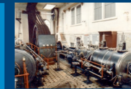
08412 Werdau, Dampfmaschinenmuseum Dampfmaschinen und NH 3 Verdichter von 1899 und 1925 www.werdau.de/werdau/content/45/30092005101212.asp
