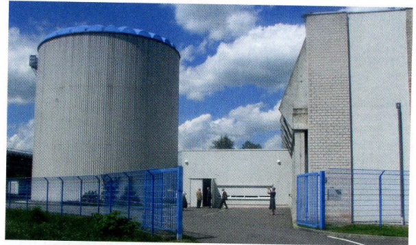
Die Zentrale der Chemnitzer Fernkälteversorgung, links der Kältespeicher
