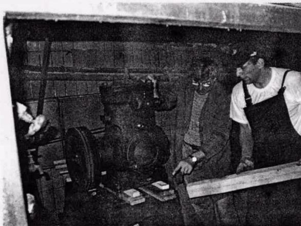
Demontage eines Linde-Verdichters durch den HKK.
